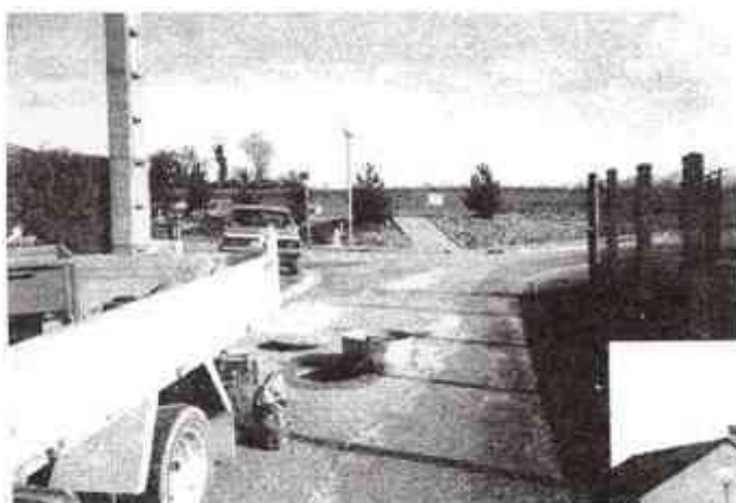
Le parking en construction
