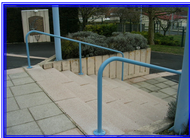
Amélioration pour sécuriser l'accès Mairie
